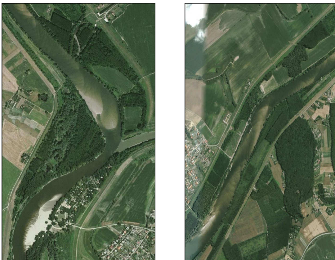
Obr. č. 3 a 4 Foto úseku pri vyústení Nitry a pri Zemnom rkm 35-32- zrejme intenzívne nánosy v koryte
